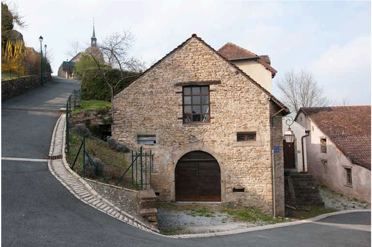
Grange : façade latérale gauche.
