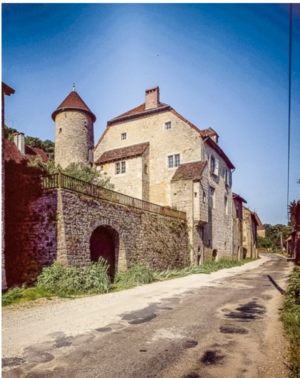
Arlay : maison du 18e siècle avec tourelle d'escalier.
