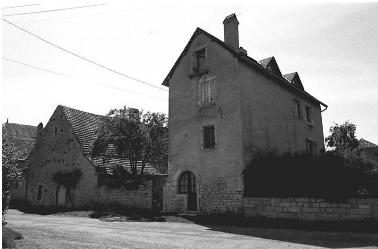
Maison située 2 rue de Bresilley.
