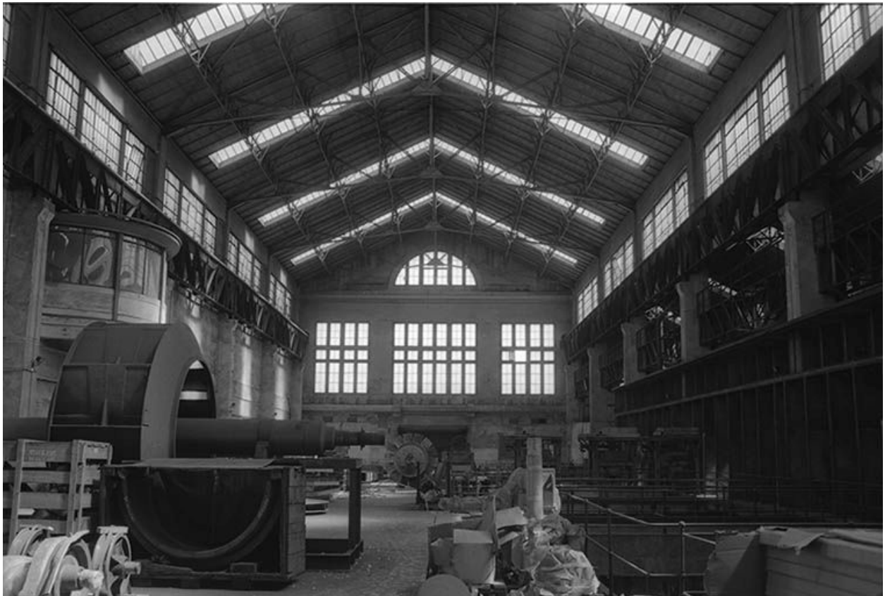
Pignon sud-est de la salle des machines vu depuis l'ancienne plate-forme des turbo-alternateurs.
