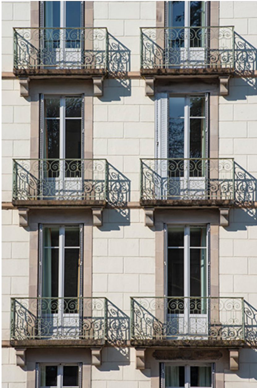
Façade sur rue de l'aile sud, détail : balcons.
