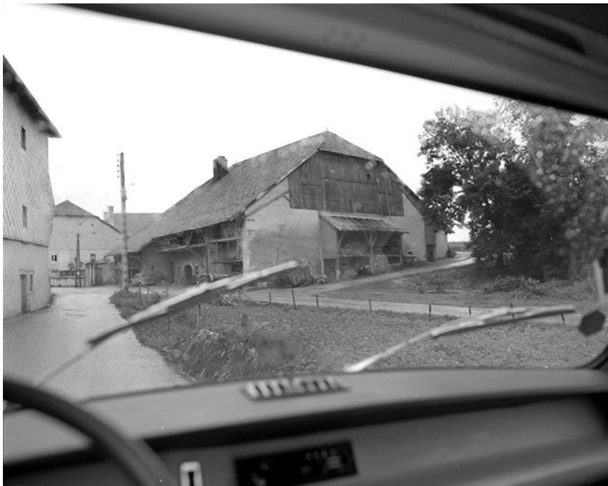
Façades postérieure et latérale droite.
