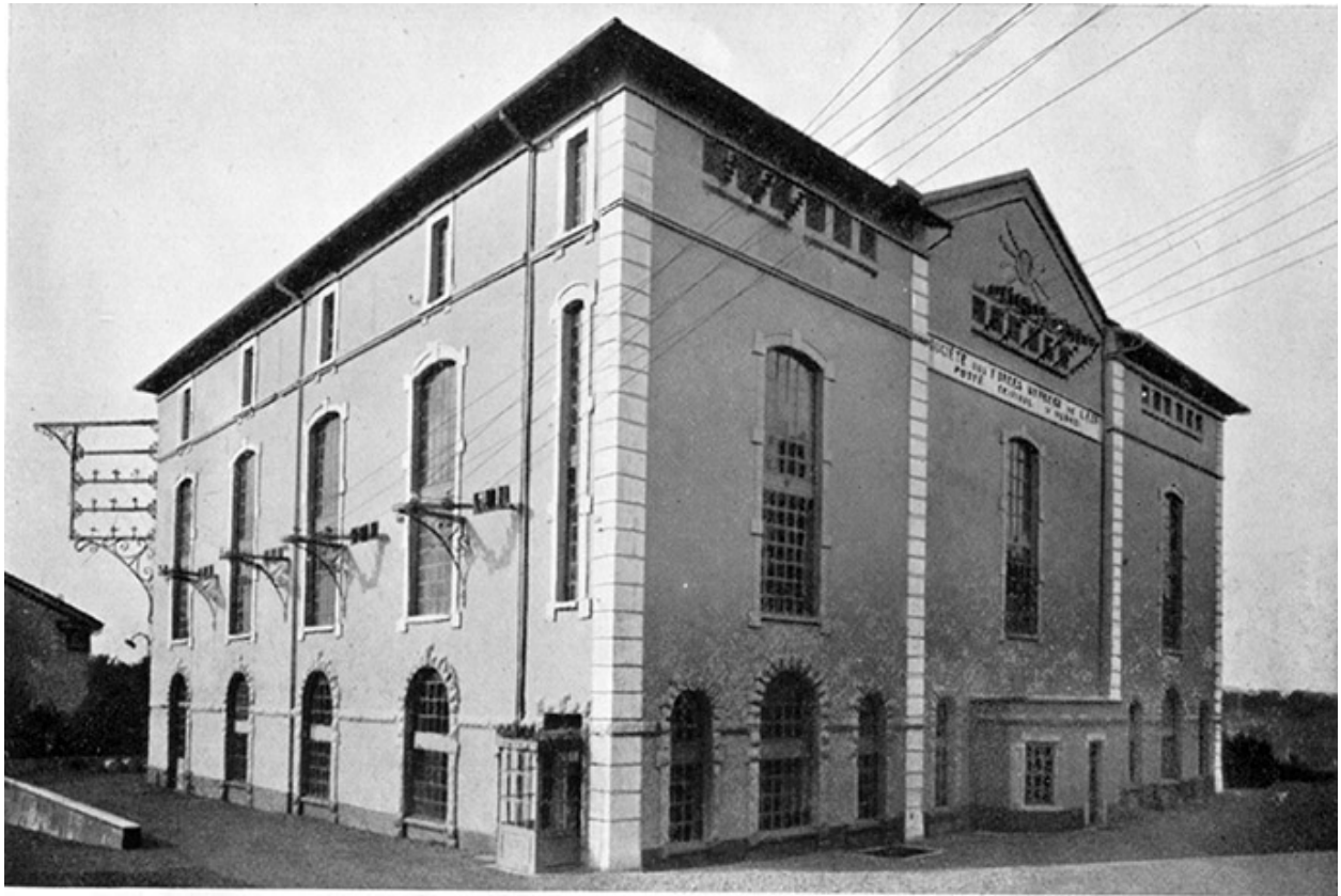
SOUS-STATION PRINCIPALE D'ÉTUPES : Vue générale.
