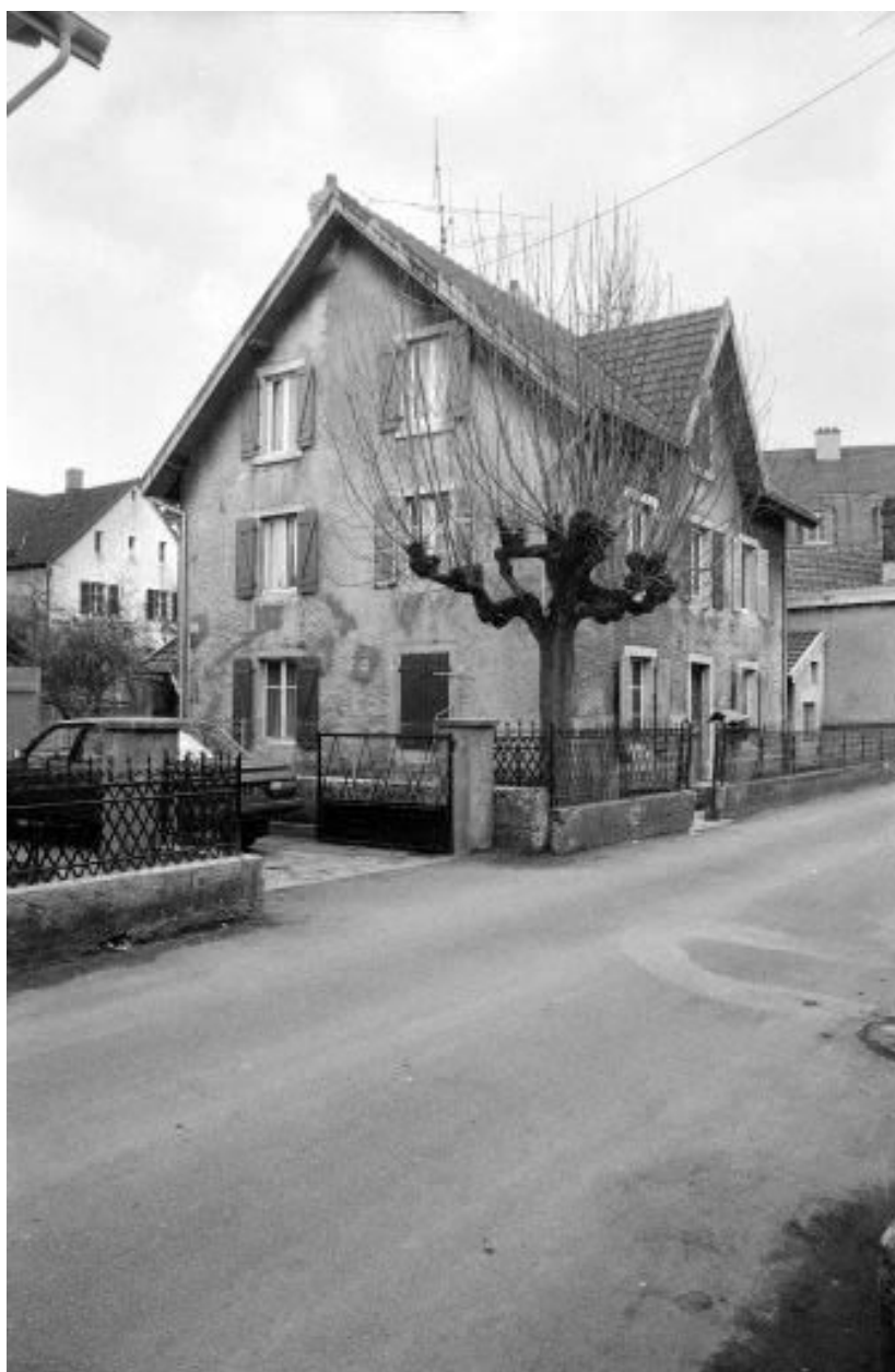
Audincourt : maison située 2 rue de la Musique.
