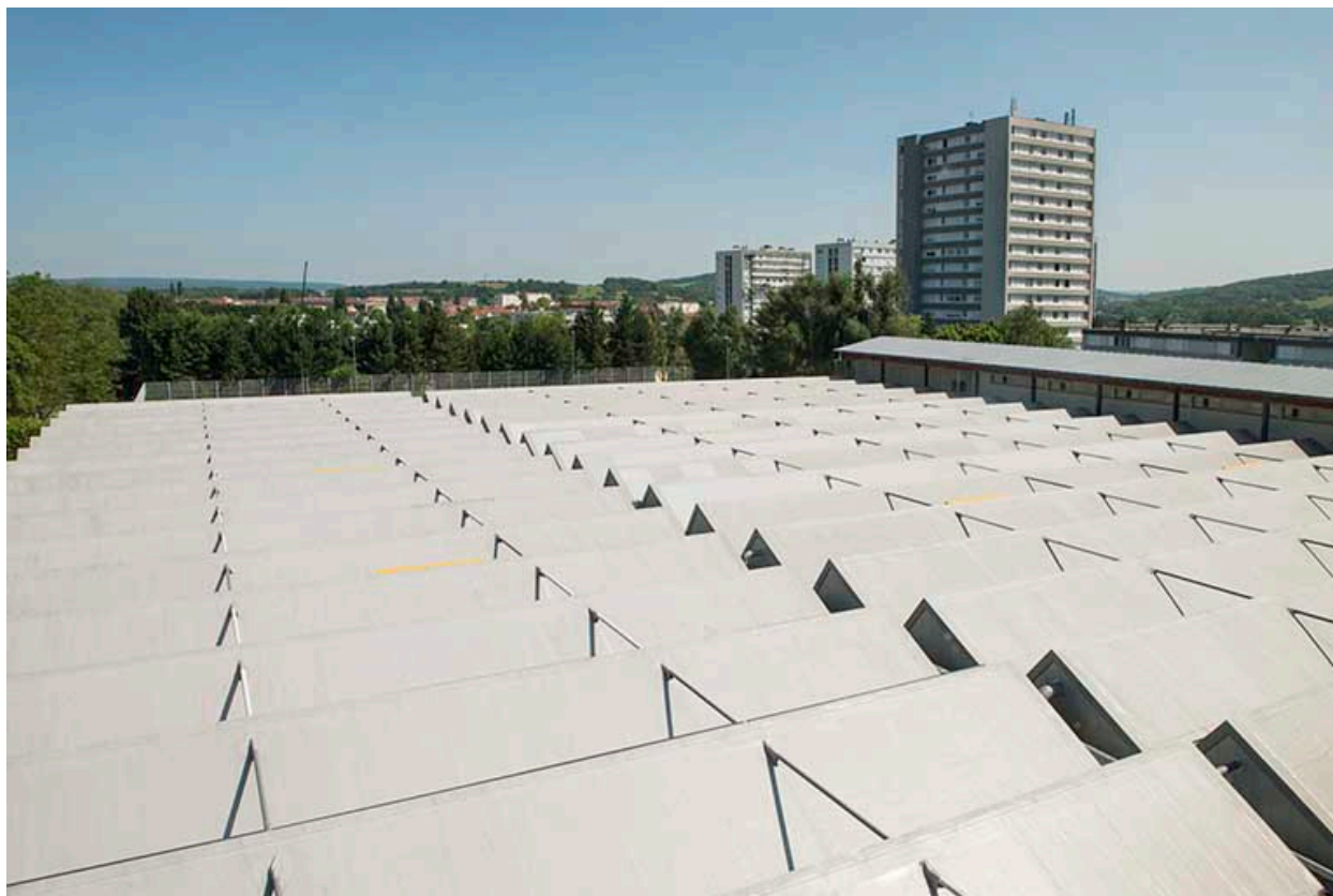
Couverture en sheds des ateliers.
