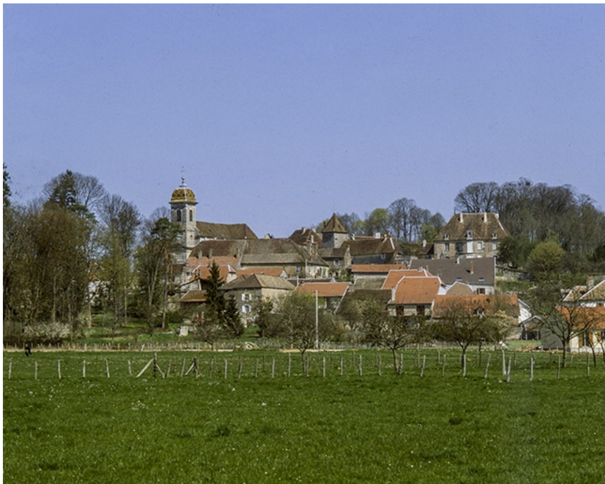
Vue d'ensemble depuis la route de Brussey.
