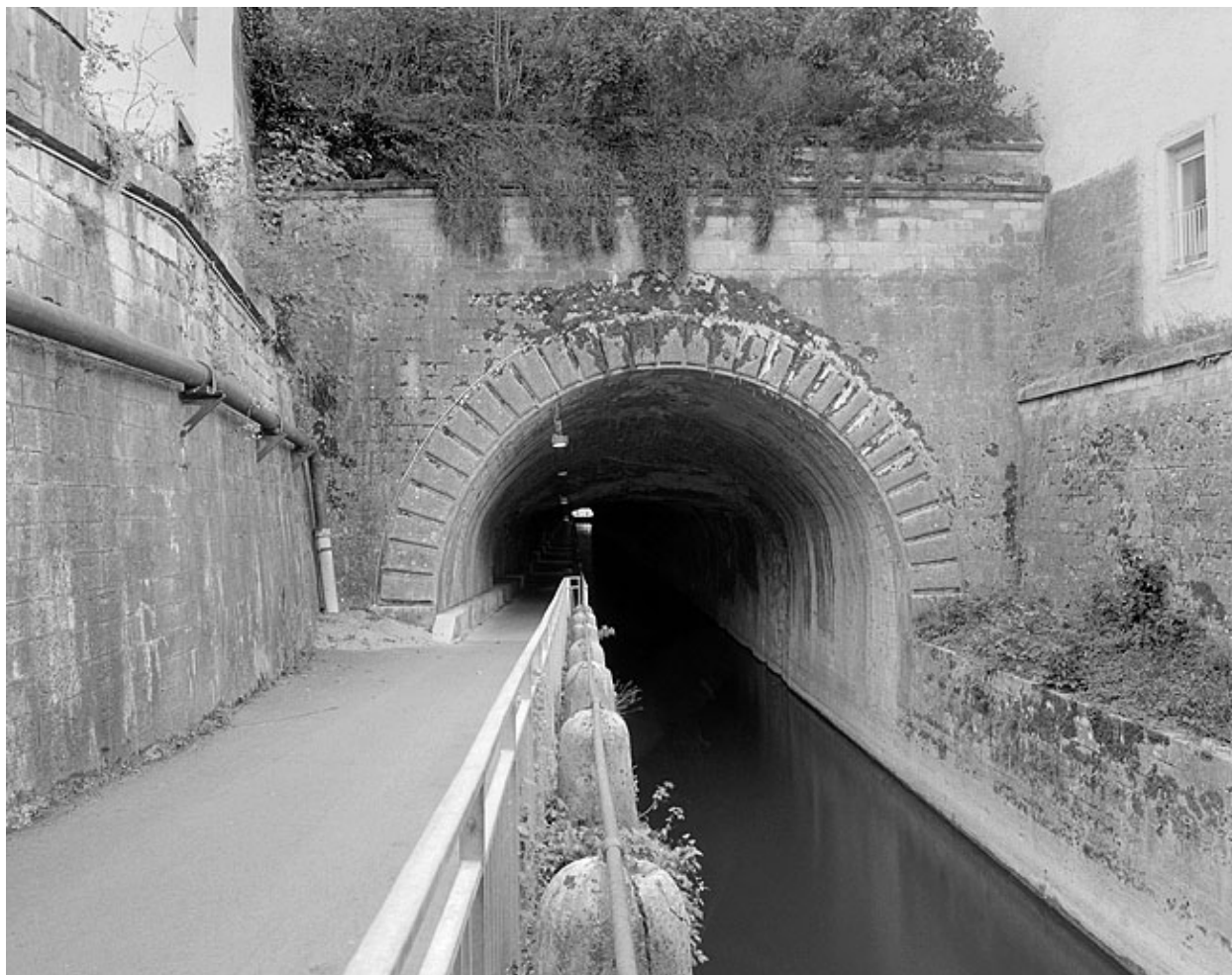
Tranchée et tête amont.
