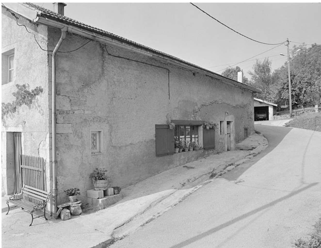
Atelier installé dans une partie de l'étable.
