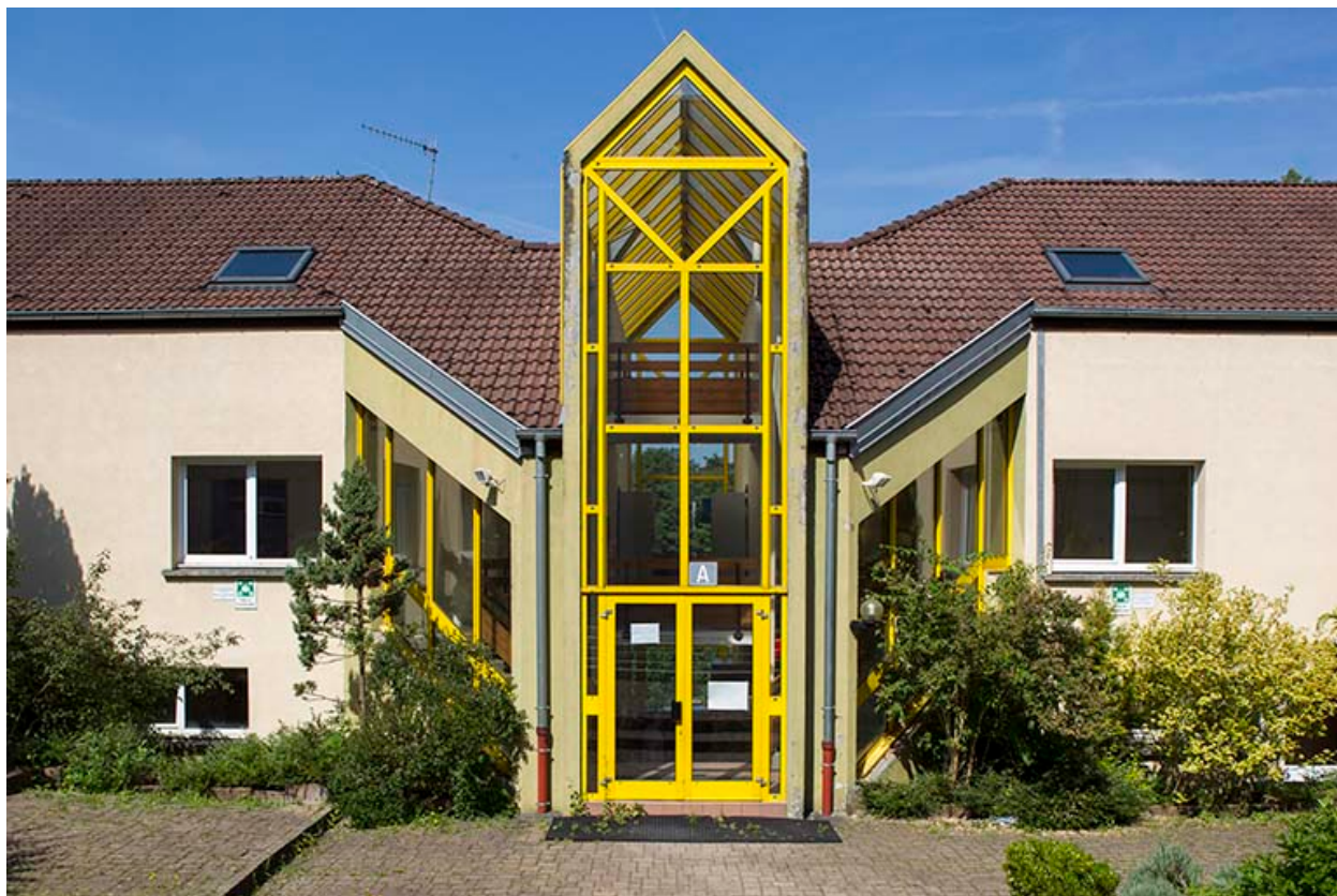
Entrée de l'externat sud-ouest.
