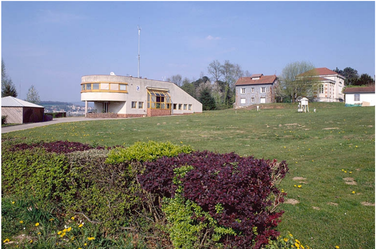
Partie nord : vue d'ensemble rapprochée depuis l'ouest.
