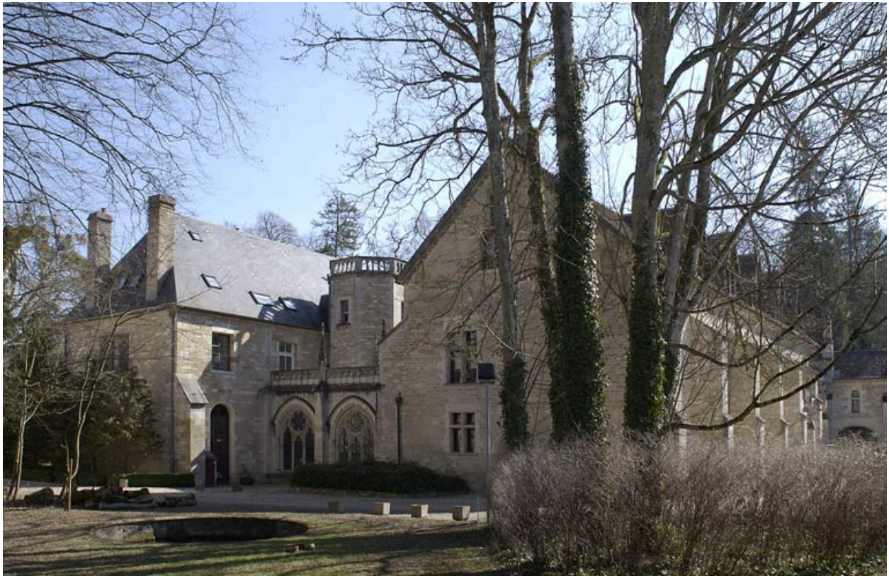
Elévation nord du bâtiment du réfectoire, de la partie sud de l'aile orientale, et de la galerie qui les relie.
