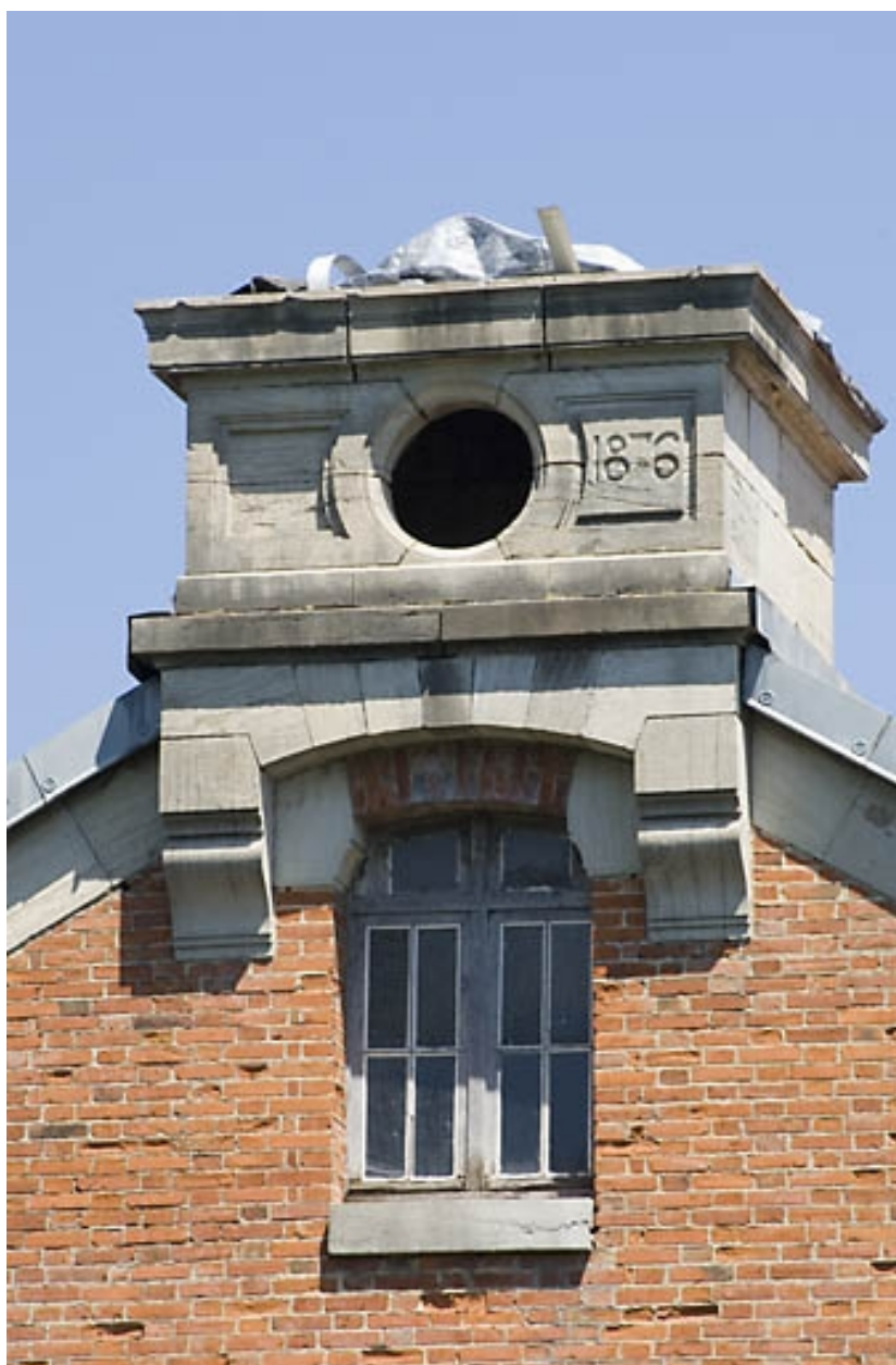
Couronnement de façade sud du bâtiment d'eau.
