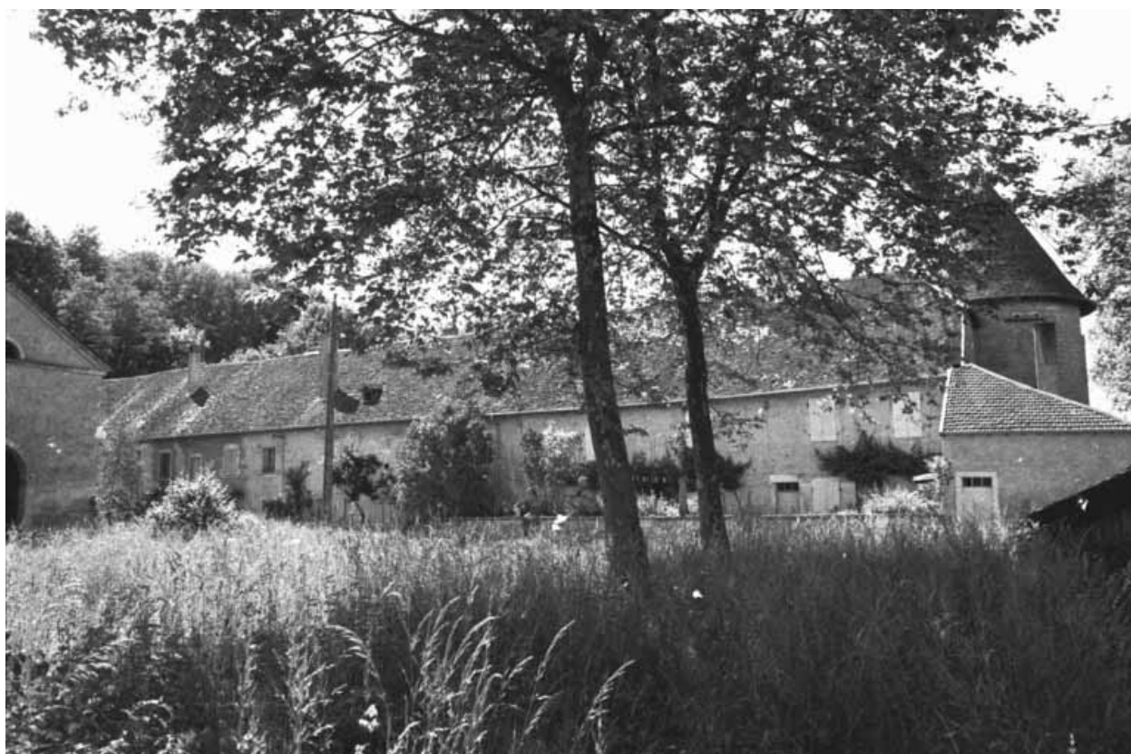
Vue d'ensemble du logement ouvrier en 1981.
