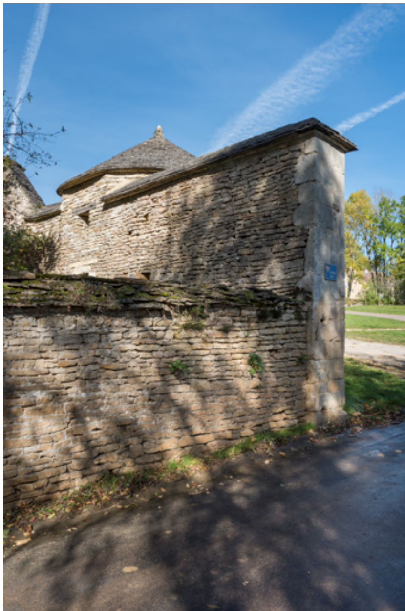
Rempart entrée ouest.
