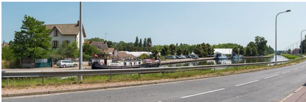
Vue d'ensemble du port.
