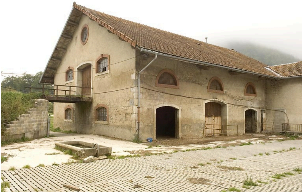
Etables et granges : façade latérale gauche, de trois quarts.
