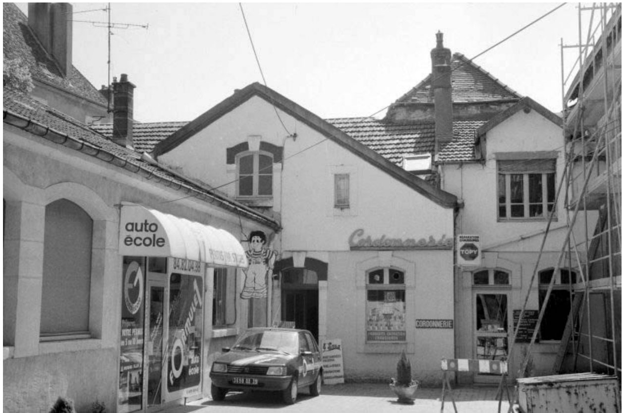
Façade antérieure du bureau.
