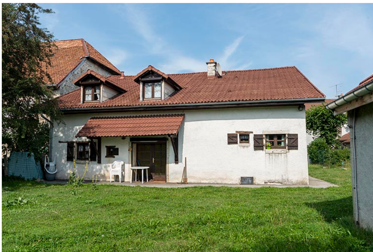
Maison au n° 47 : façade postérieure.
