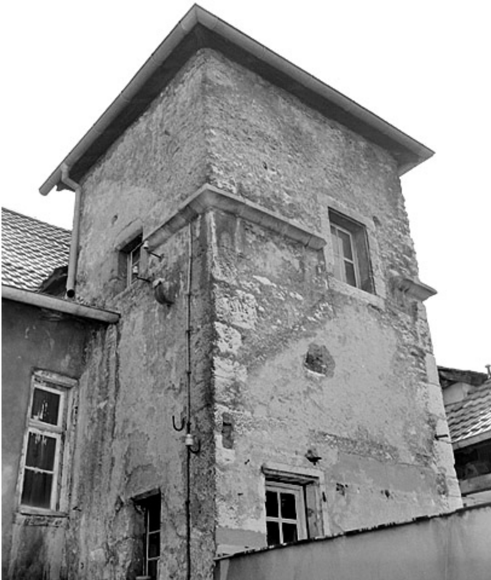
Maison 15, rue des Febvres. Tour d'escalier. La tour porte la date 1570.
