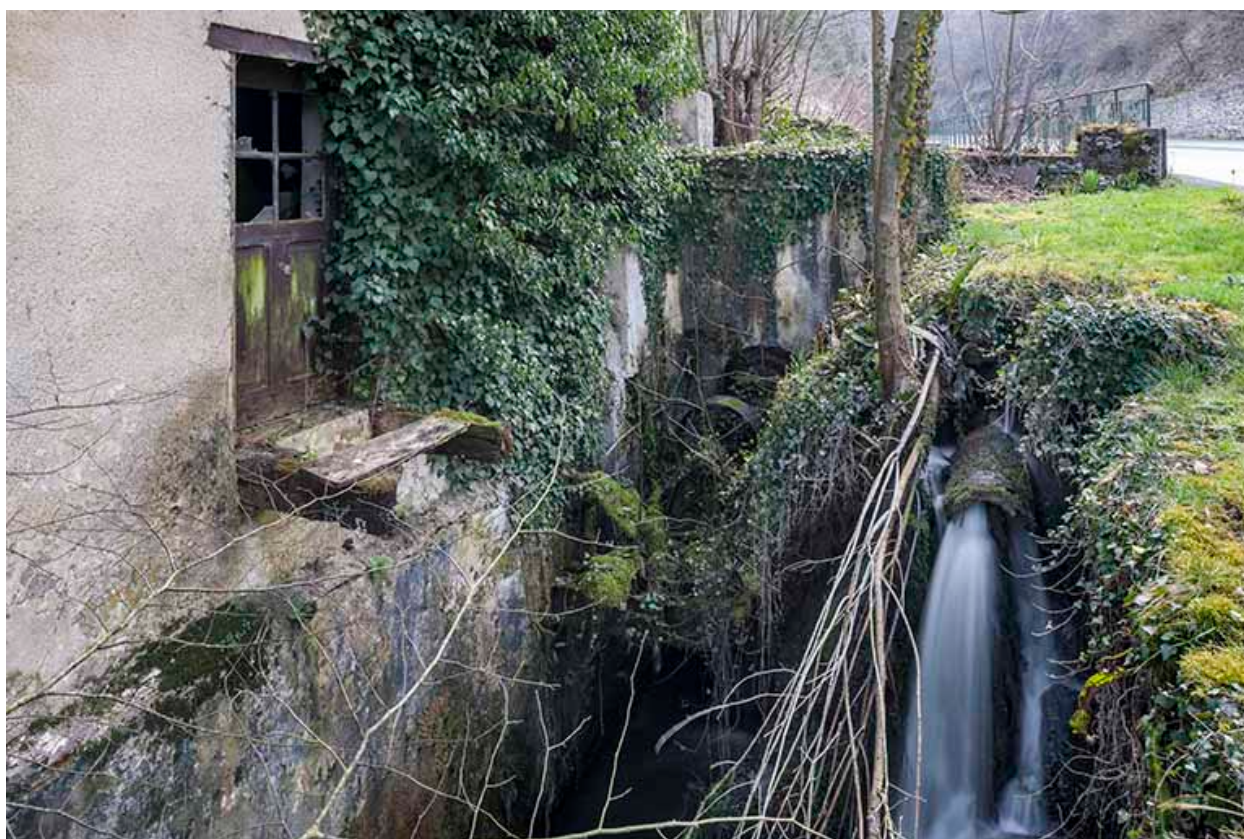
Canal d'amenée et vestiges de la turbine.
