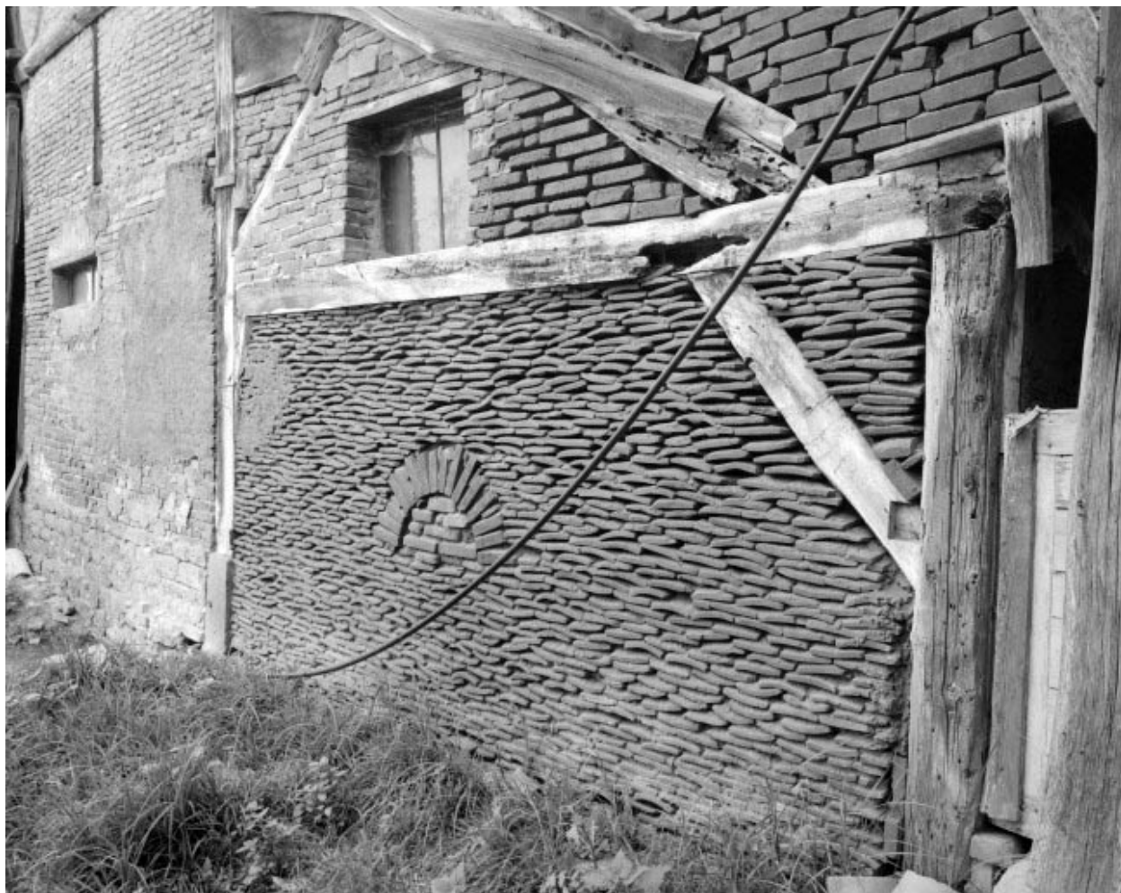
Façade ouest de l'écurie. Détail du pan-de-bois hourdé de tuiles et briques.
