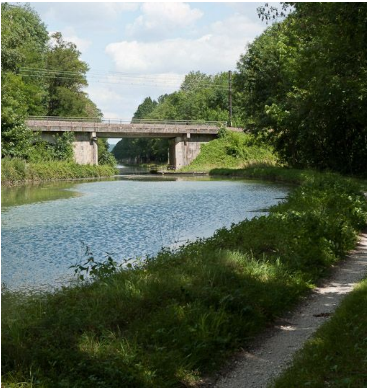
Vue du pont.
