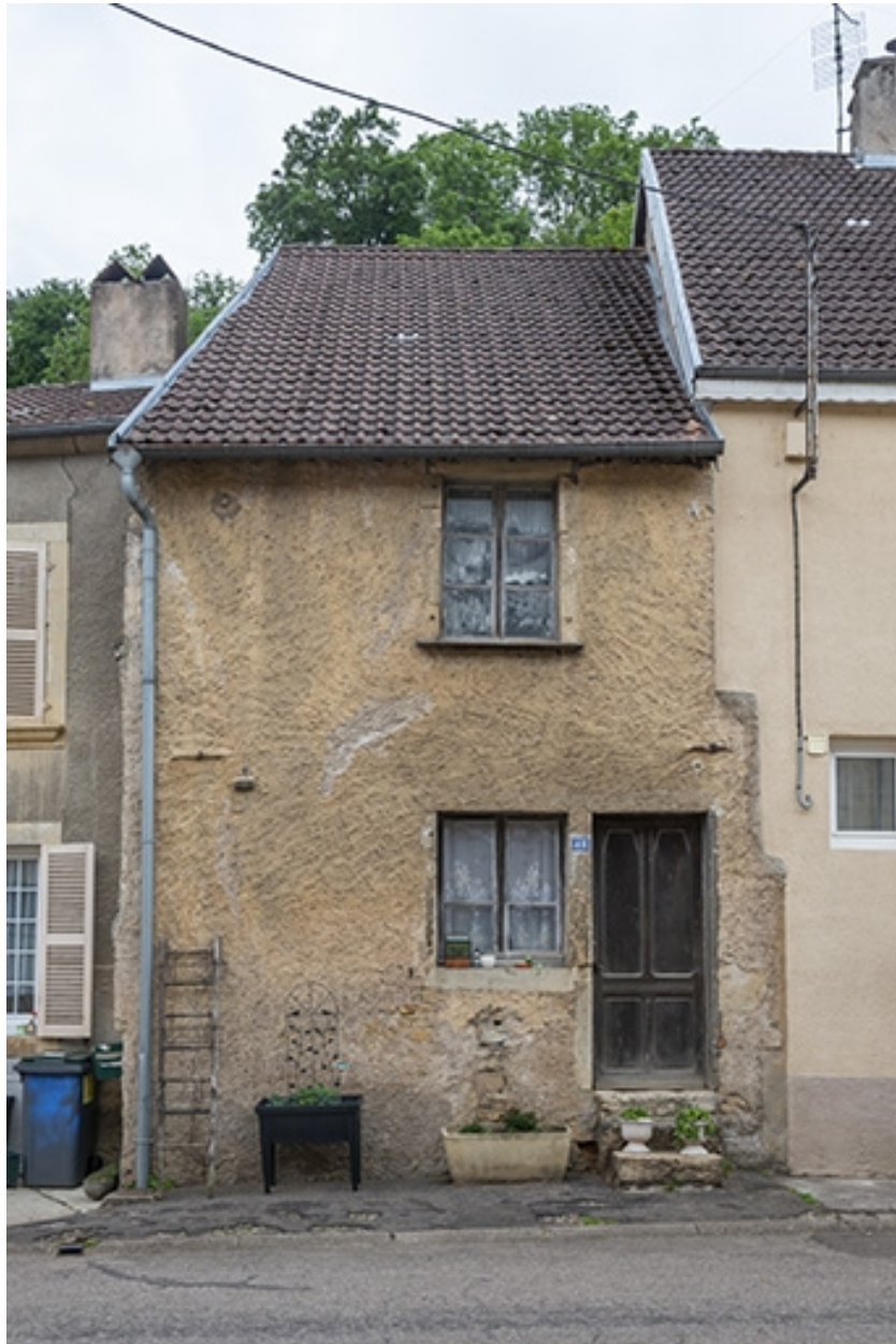
Rue Thiers, façade de la maison au n° 48.
