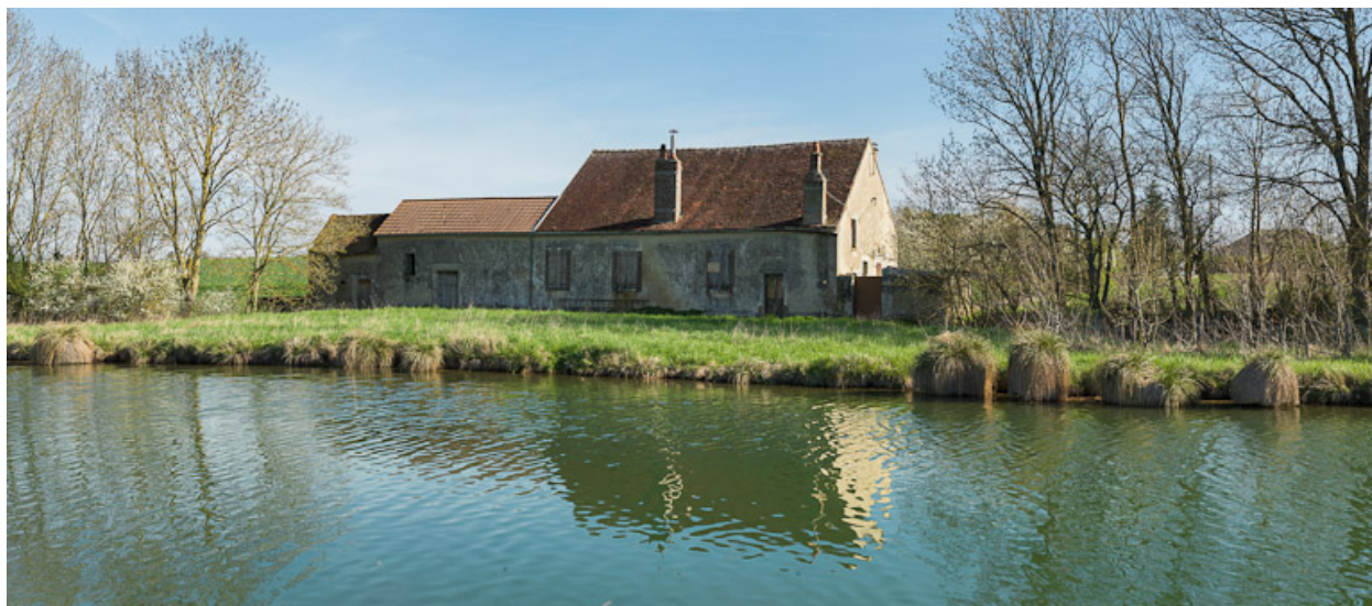
Les petits bâtiments en aval du port.
