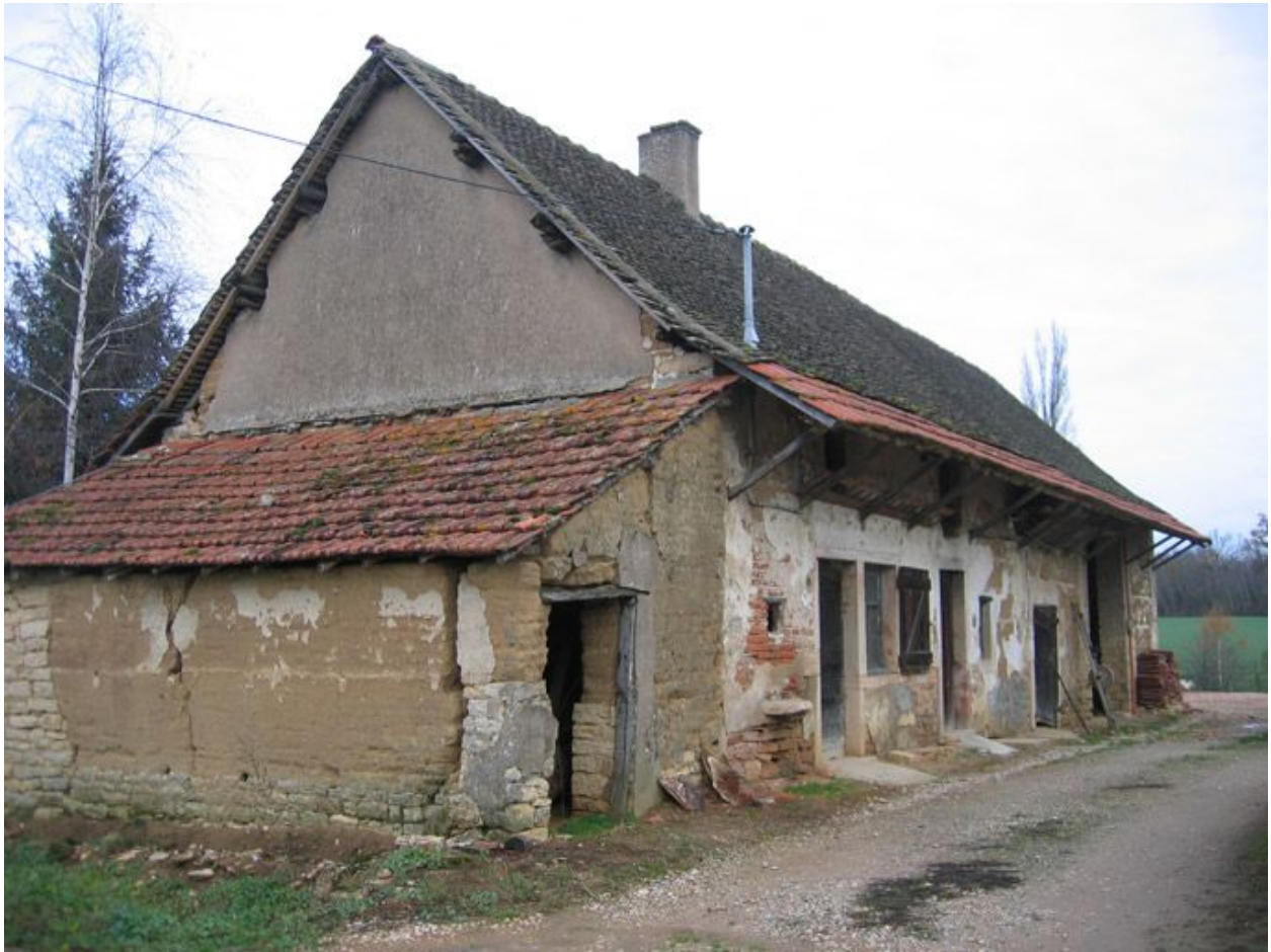
Vue d'ensemble de la façade.
