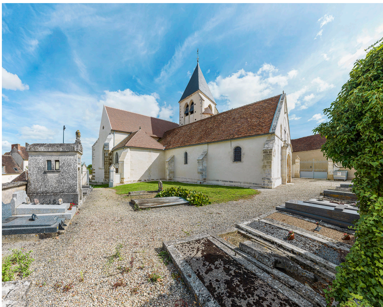
Vue d'ensemble de l'élévation nord, depuis le cimetière.
