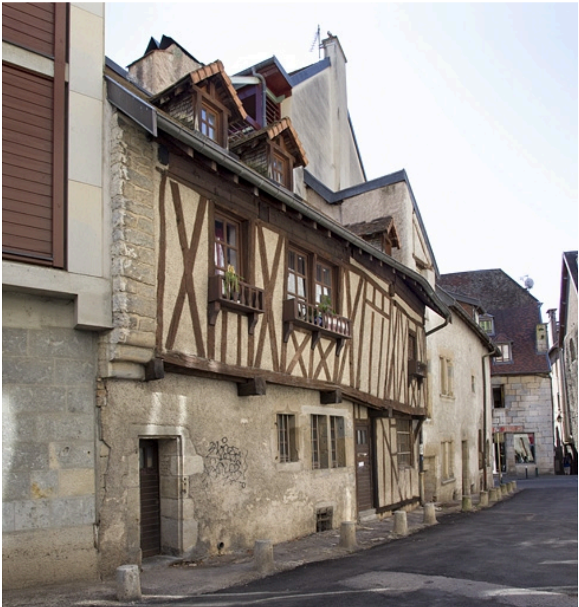
Maison : vue d'ensemble de la façade antérieure à pans de bois, de trois quarts gauche.
