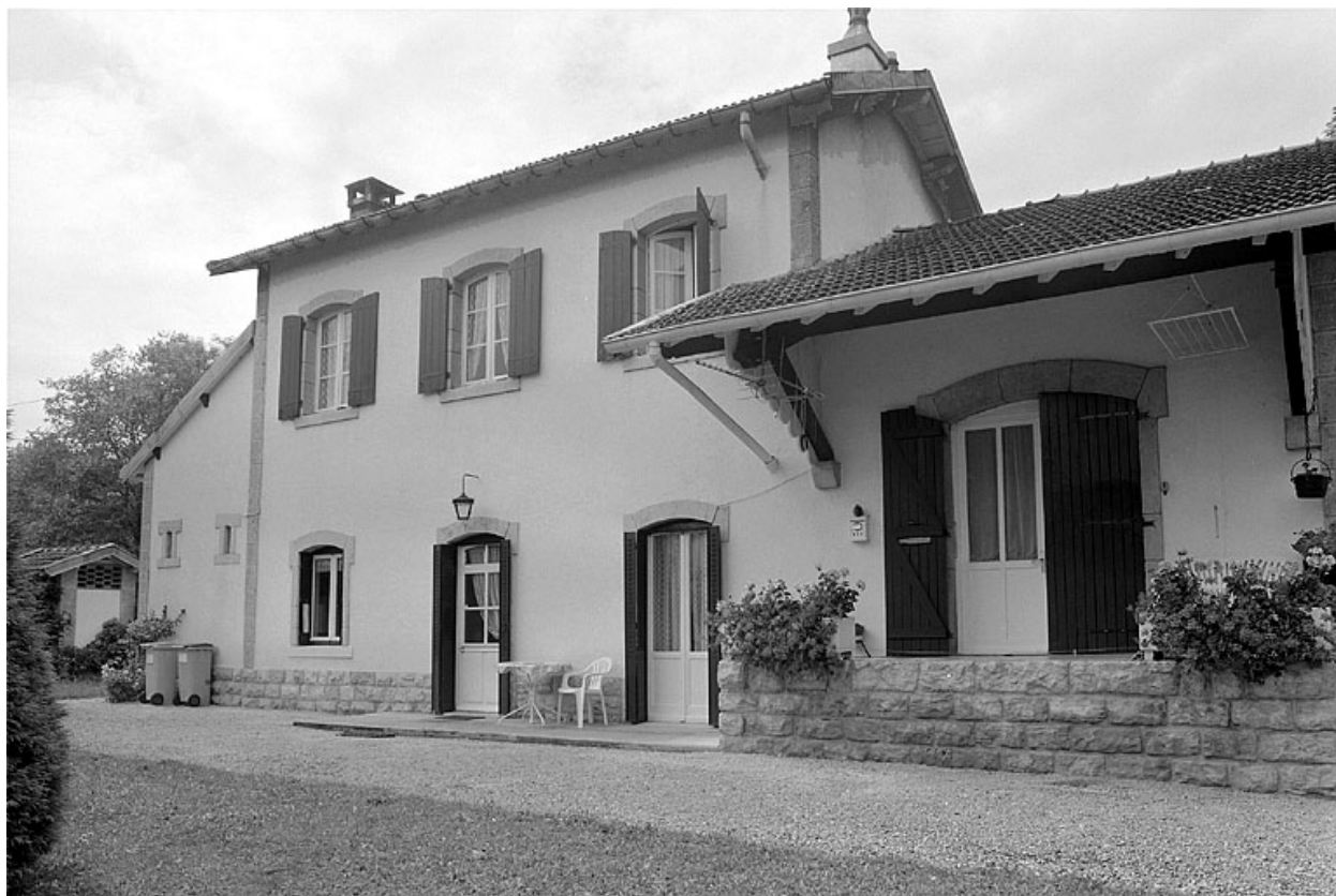
Façade sur la voie ferrée.
