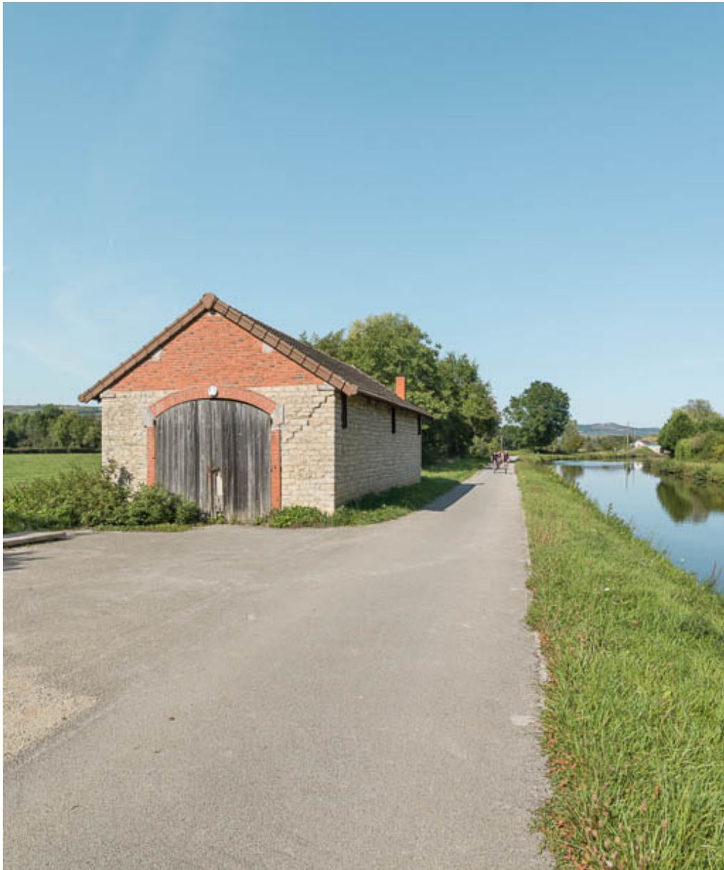
Vue d'ensemble de la remise, rive gauche.
