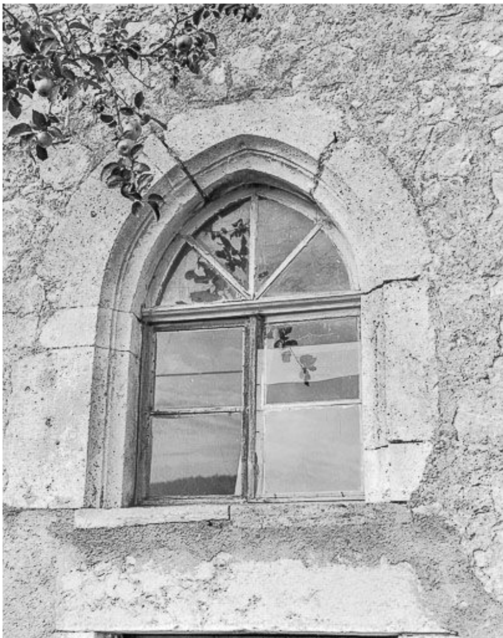
Détail de la façade sur rue : fenêtre.
