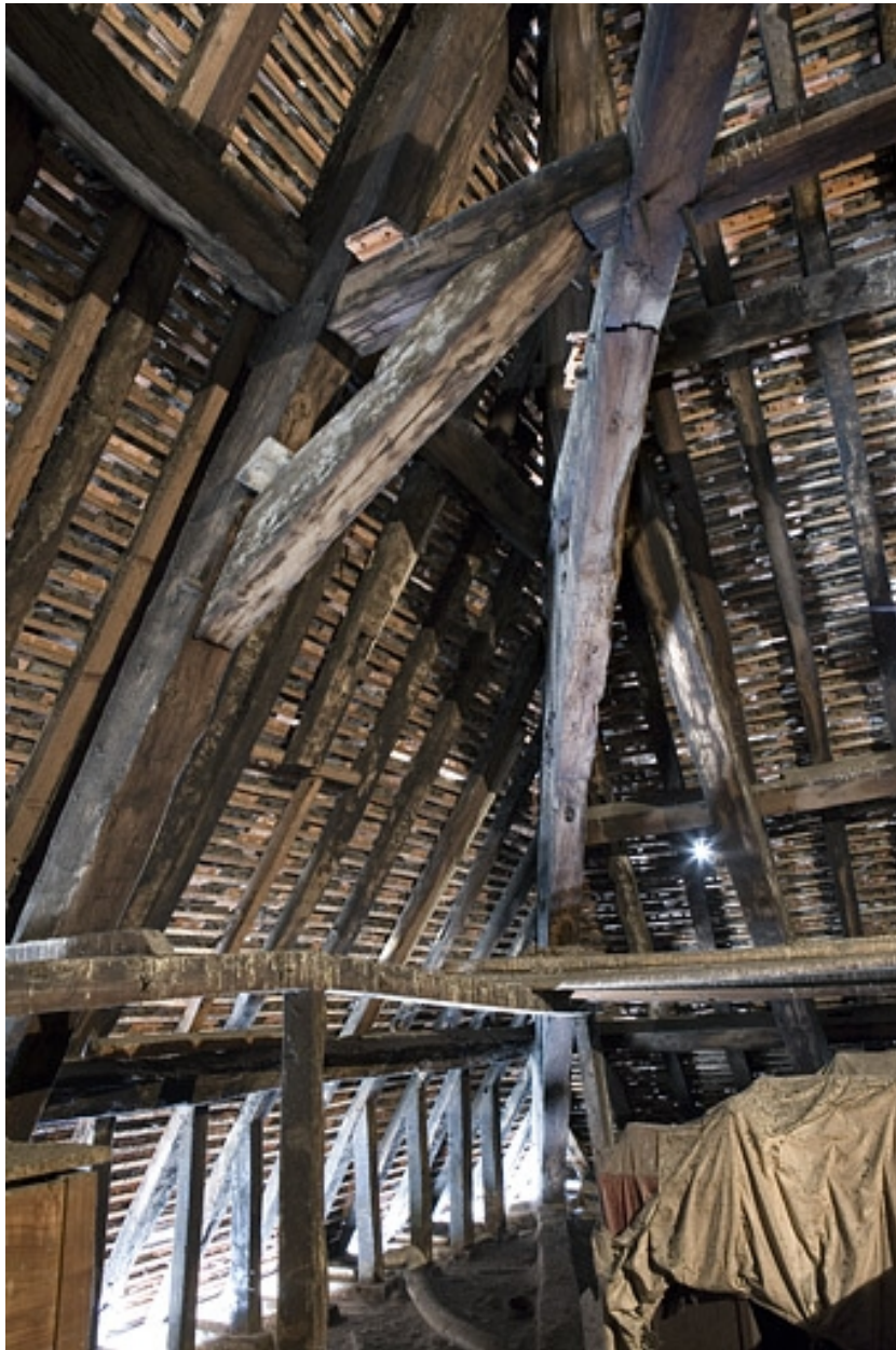
Intérieur, comble : détail de la charpente côté cour.
