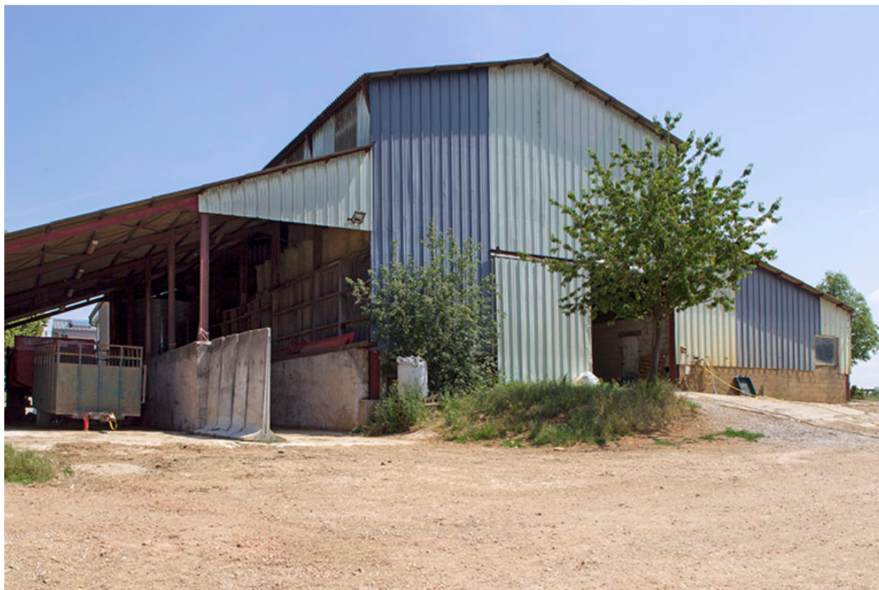
Pignon sud de l'entrepôt agricole.
