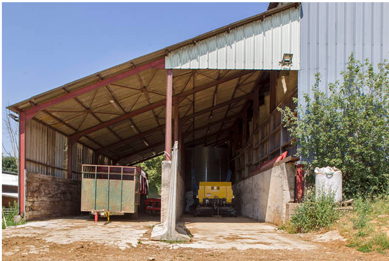
Appenti à l'ouest de l'entrepôt agricole.
