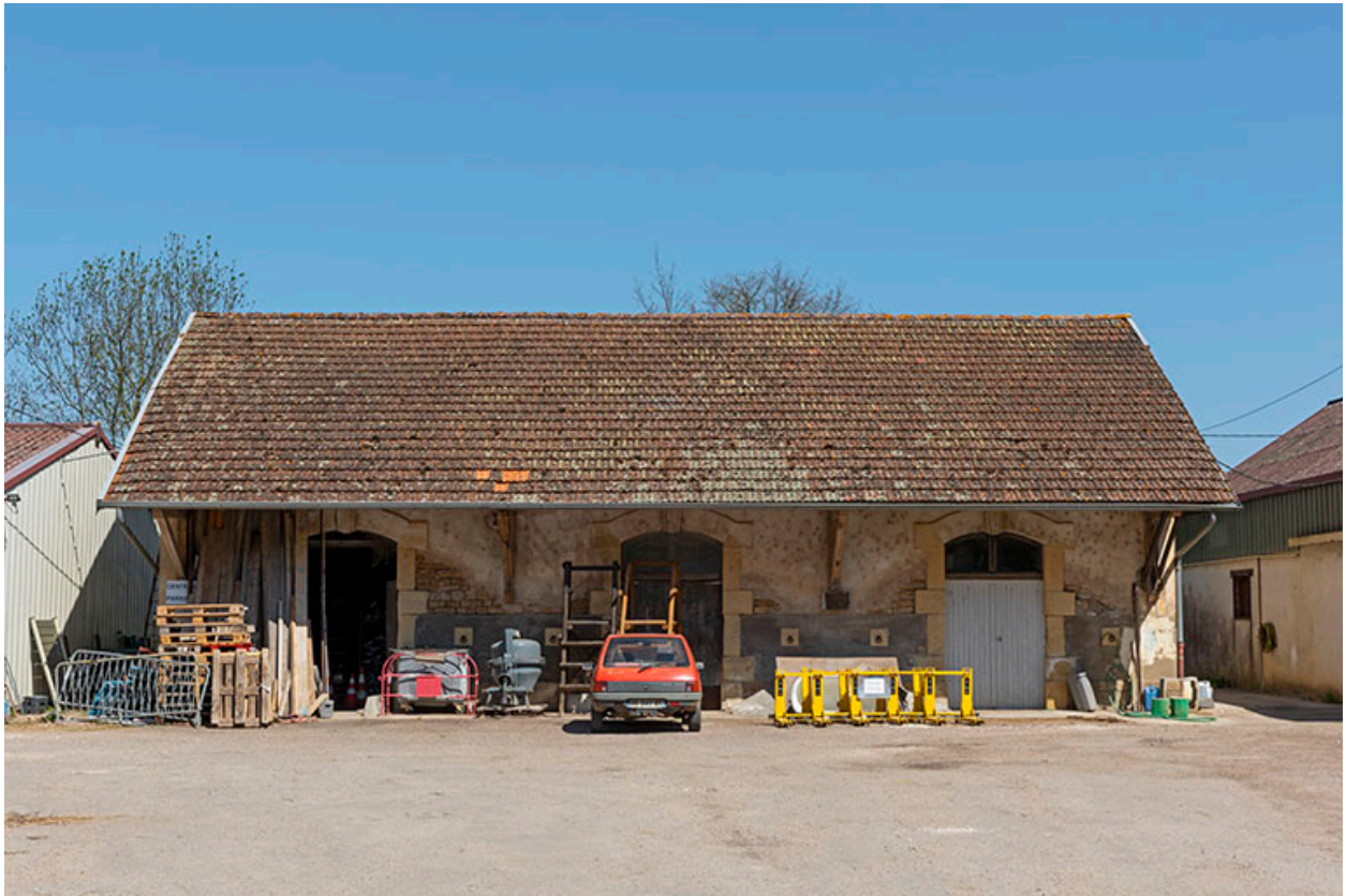
Le bâtiment central, de face.
