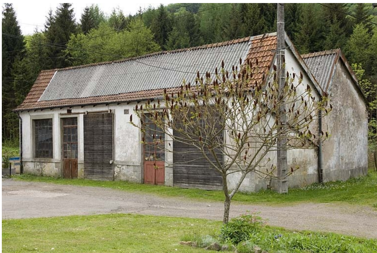
Atelier de réparation (menuiserie, forge).
