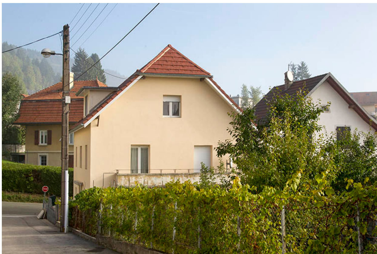
Façade latérale droite.
