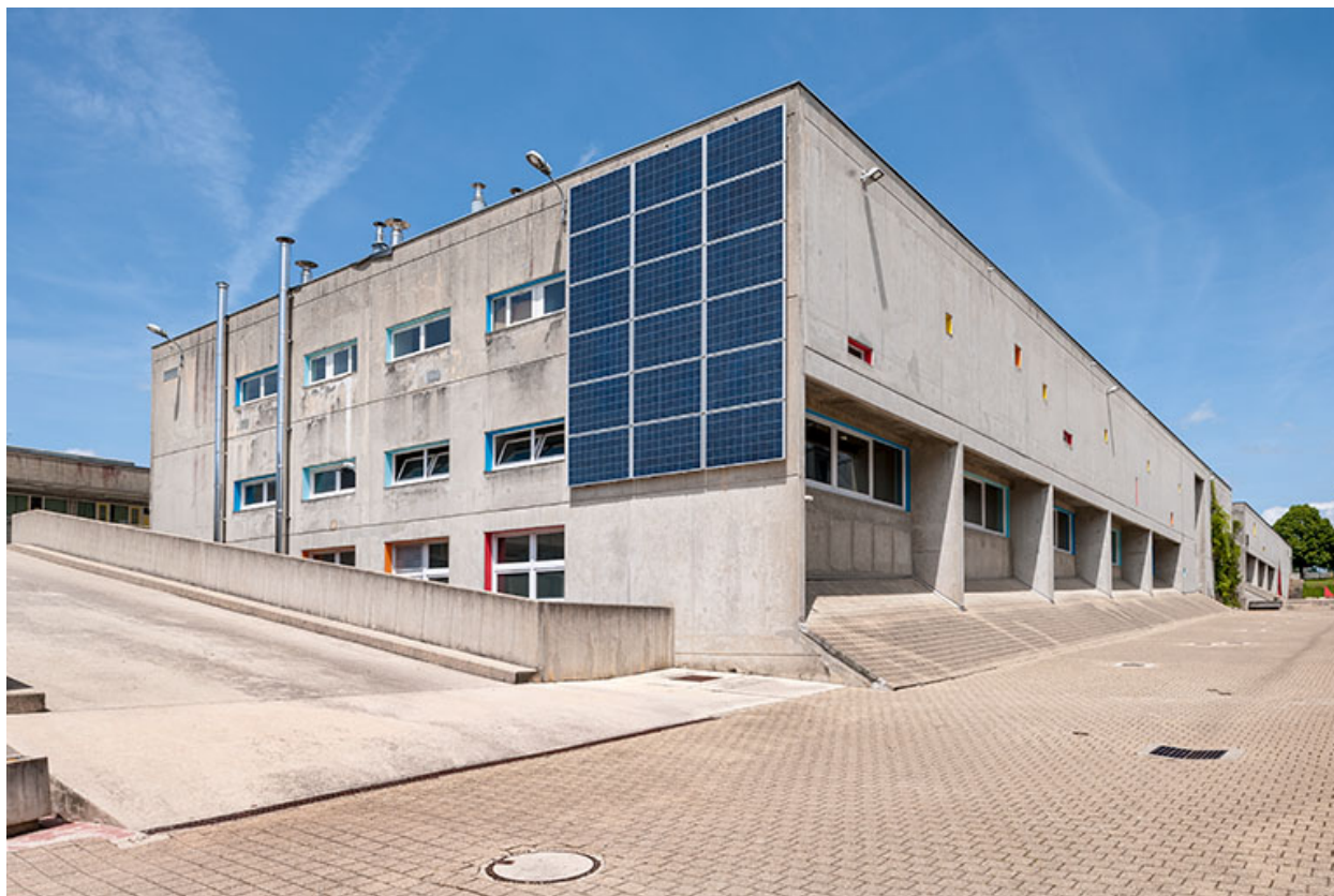
Atelier métal : pignon sud
