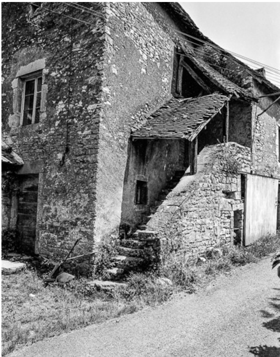
Détail de l'escalier.
