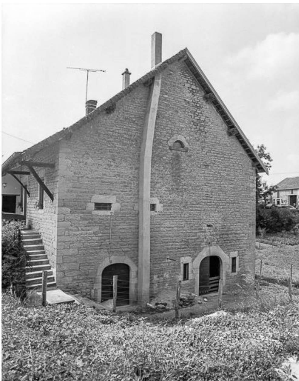
Façade latérale droite.
