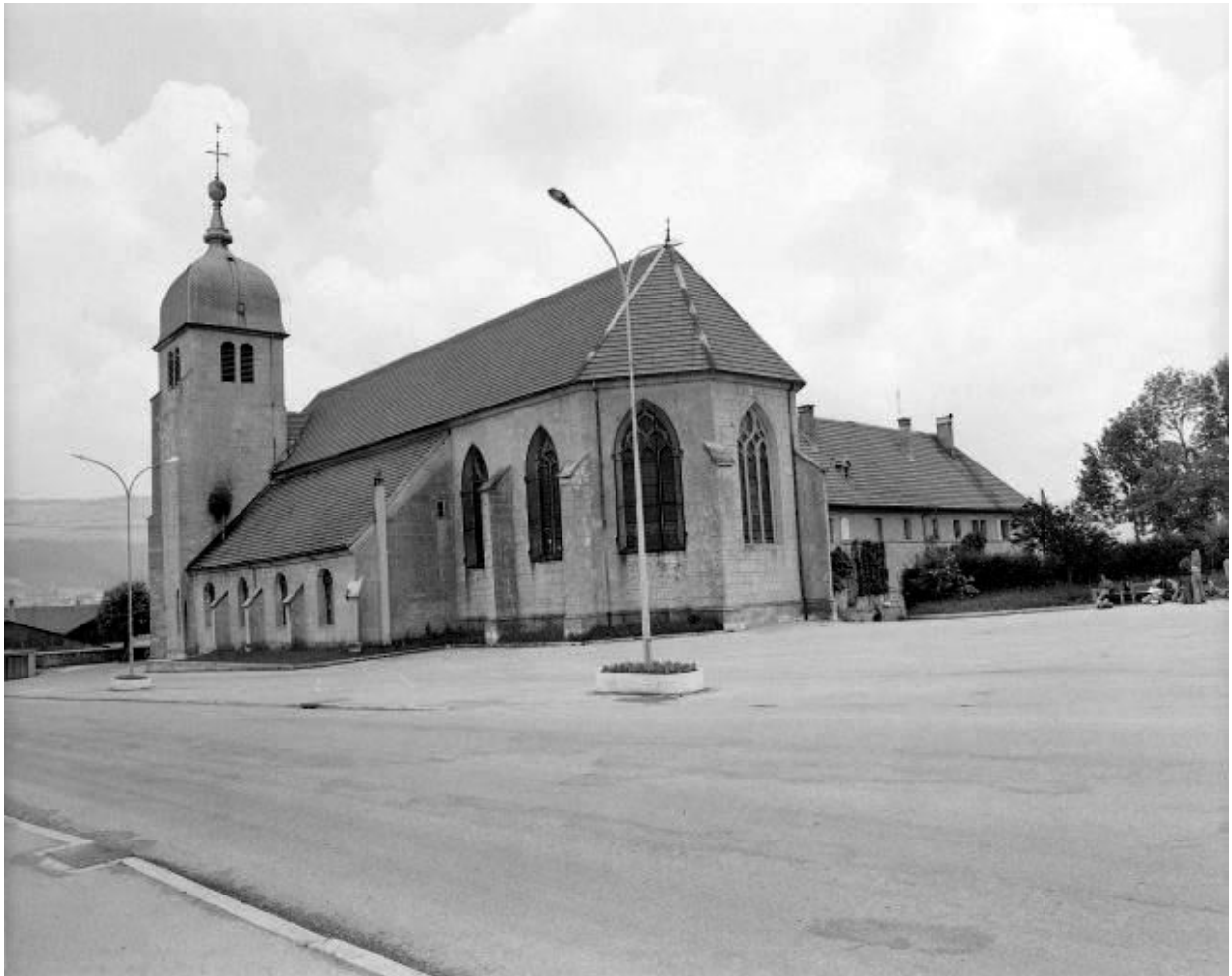
Chevet et façade latérale droite.
