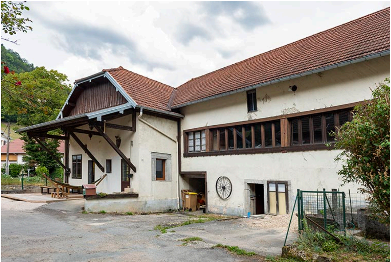
Forge : façade ouest (côté cour).
