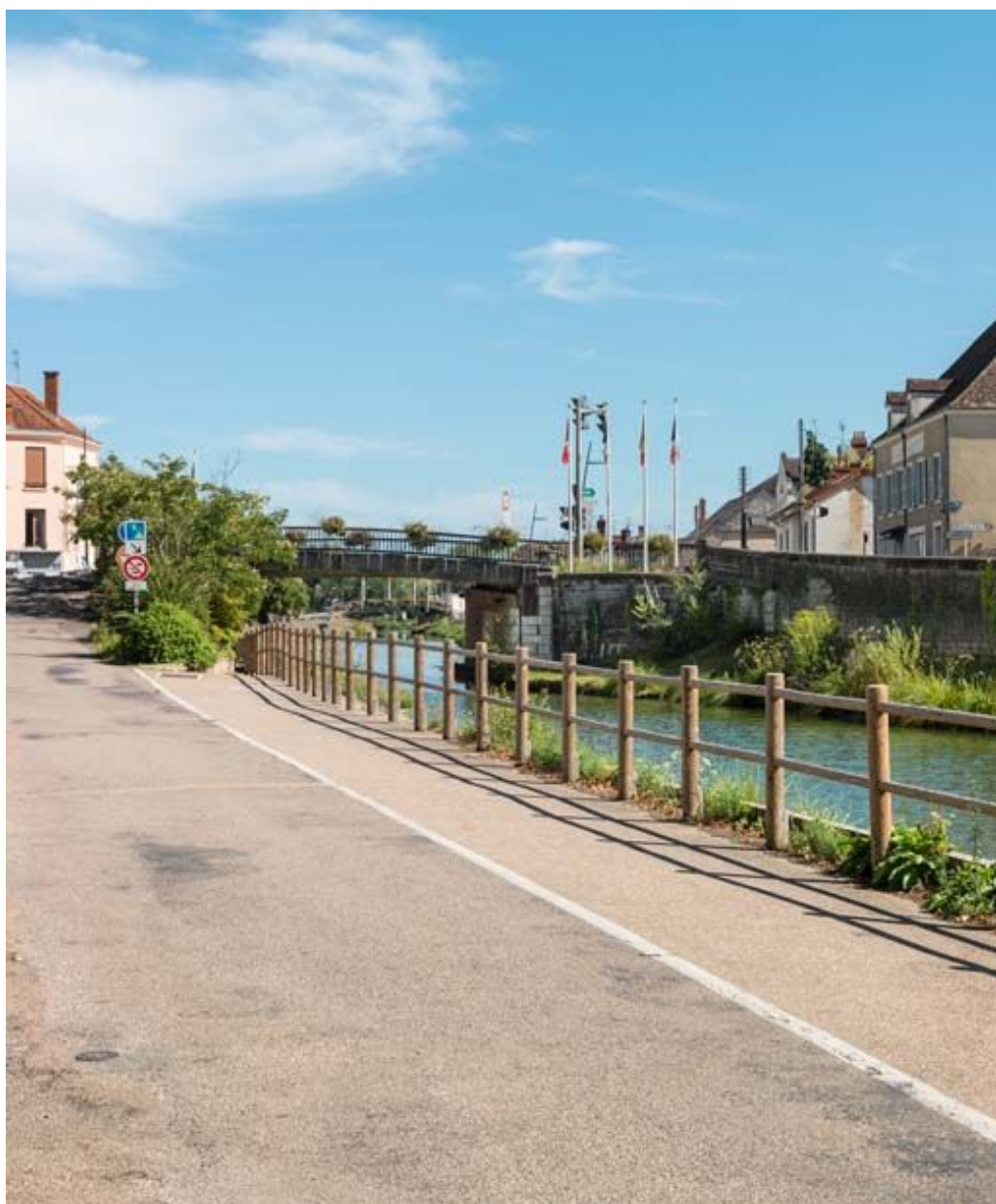
Vue d'ensemble du pont.
