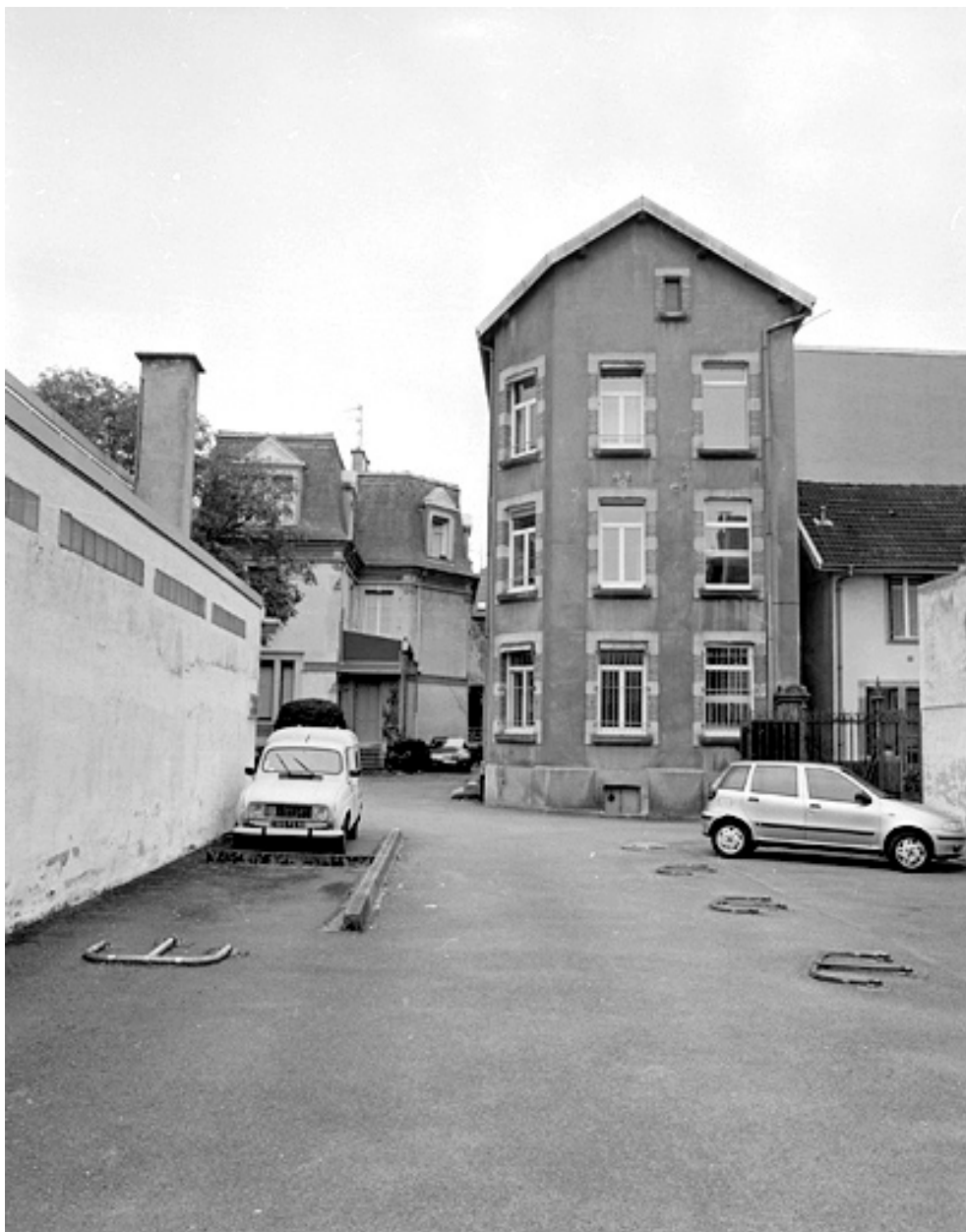
Logement patronal situé à l'arrière du n° 25.
