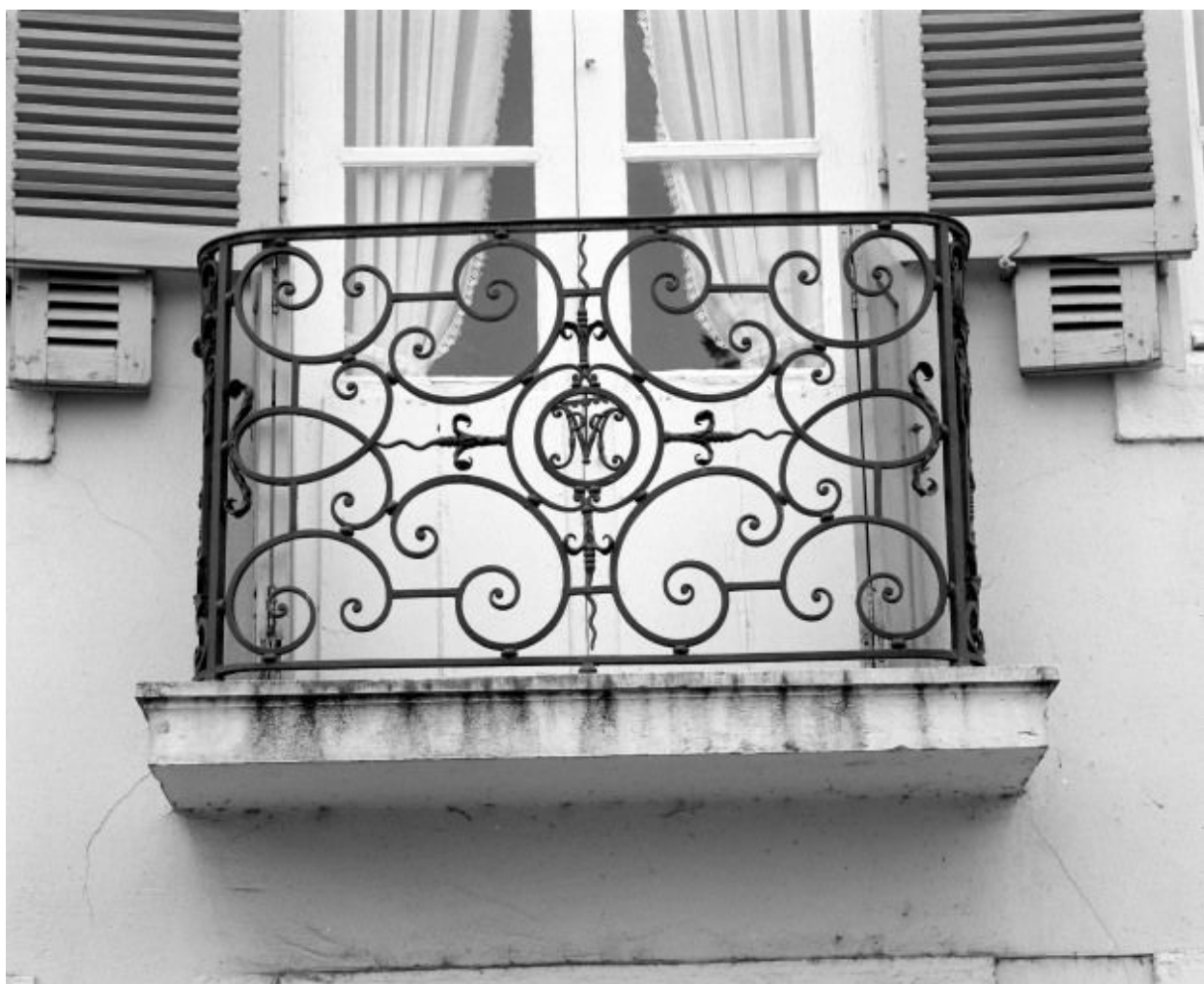
Maison située 2 place de la Liberté (cada. 1977, sect. AD, parc. 115) : grille du balconnet.
