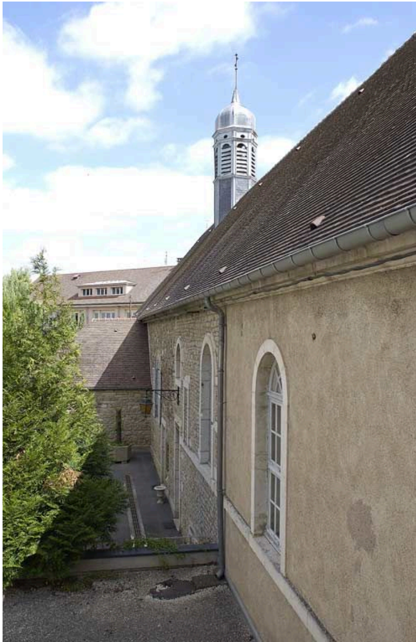
Façade postérieure et extension de la salle des hommes.
