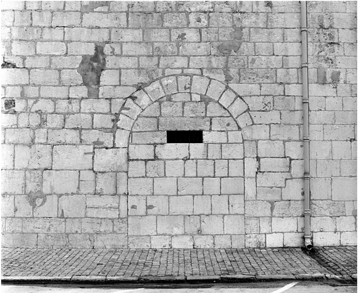
Détail de la porte murée à hauteur de la première travée du collatéral sud.
